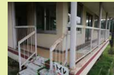
▲入口階段側【改善前】
